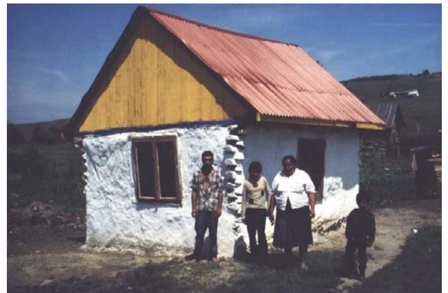
Zustand des Einzimmer-Hauses nachher
