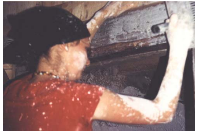
Kalken der Wände
