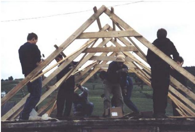
Errichten des Dachstuhles
