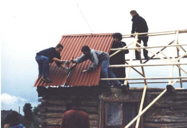
Decken des Daches
