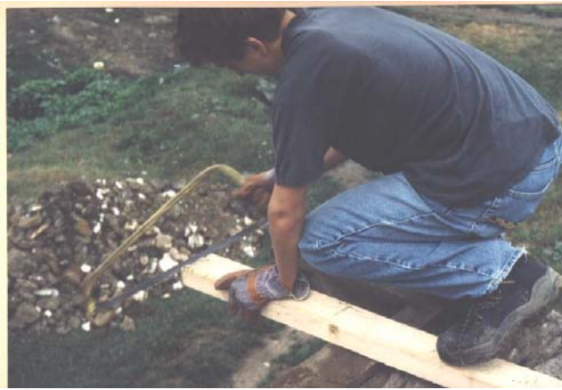
Zusägen des neuen Dachstuhl
