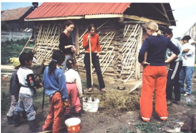
Anrühren des Lehm-Pferdemist-Verputzes
