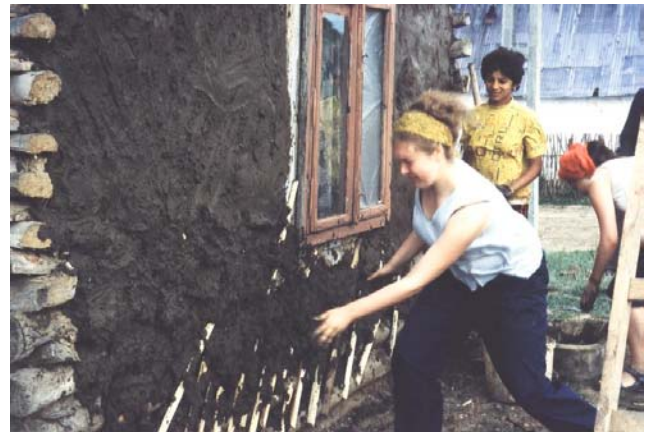
Verputzen der Wände
