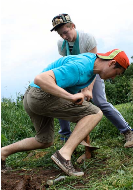
Bohren der Löcher für den Zaun
