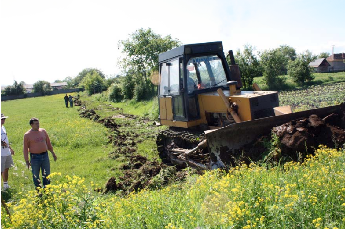
Der Bulldozer begradigt den Sportplatz
