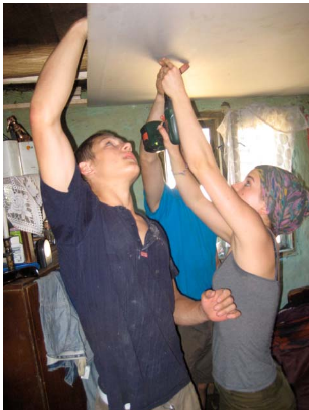
Montage der Rigibsdecke
