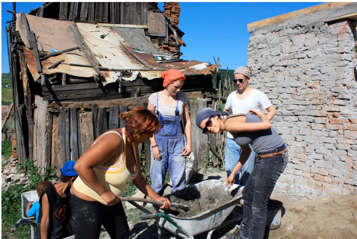
Verputzarbeiten am Haus
