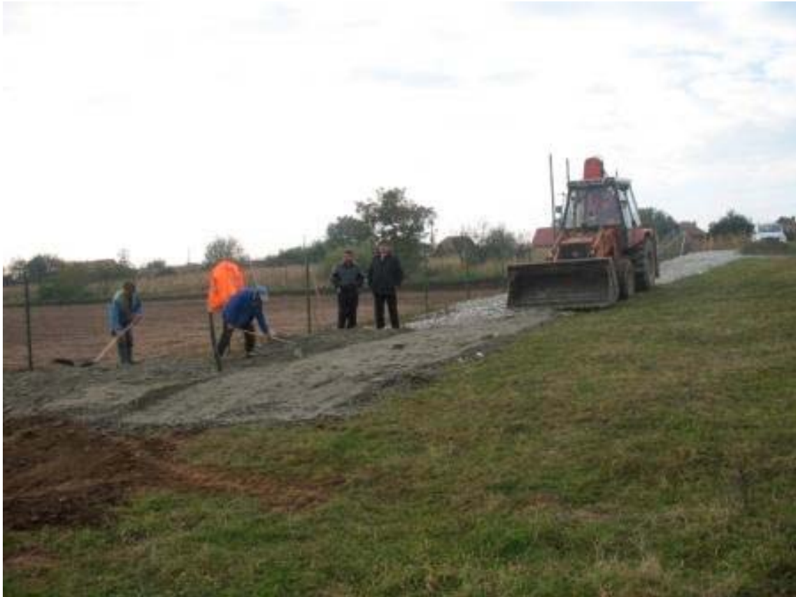
Bau der Zufahrtsstraße zum Fußballplatz durch die Gemeindearbeiter
