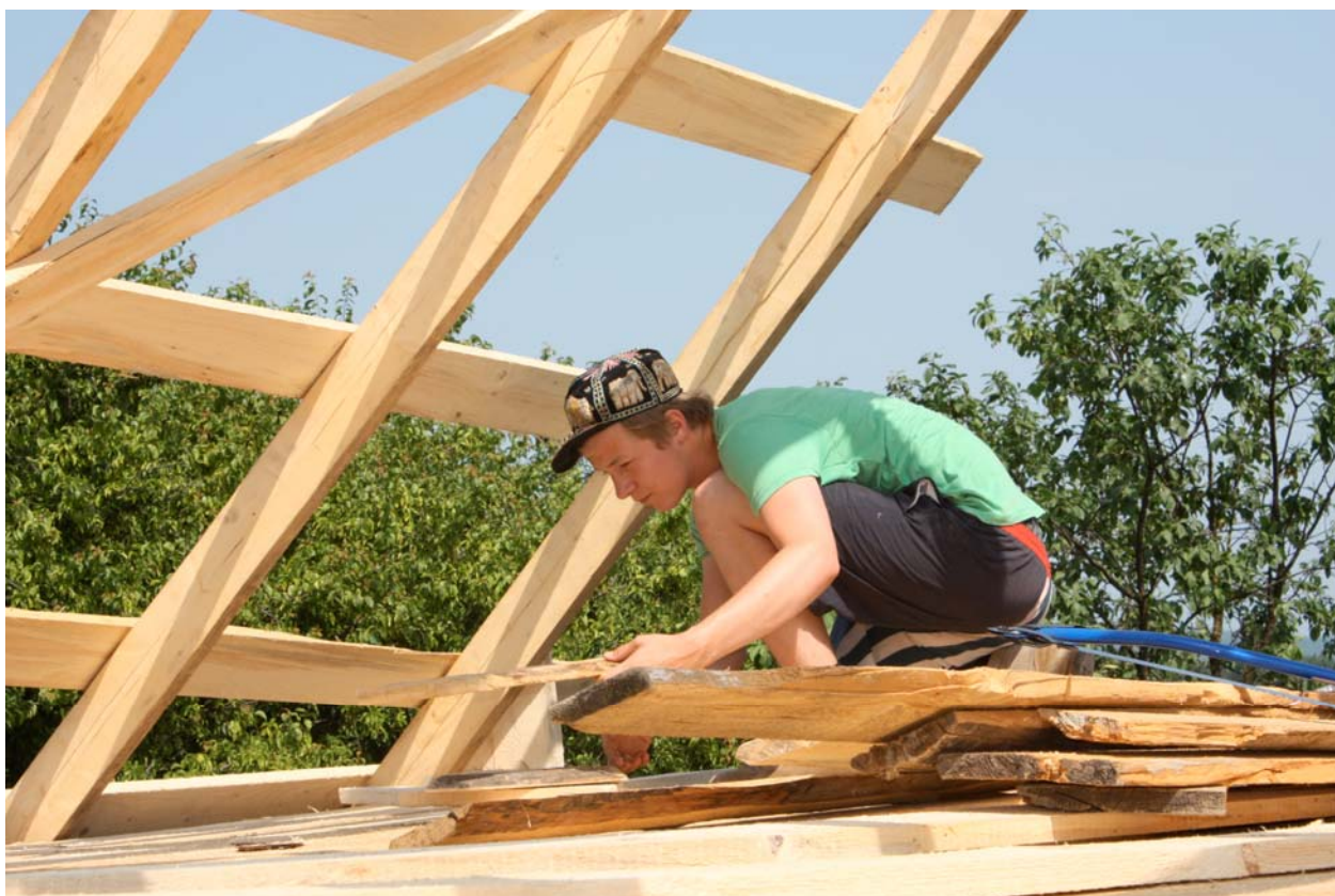
Bau des Dachstuhles
